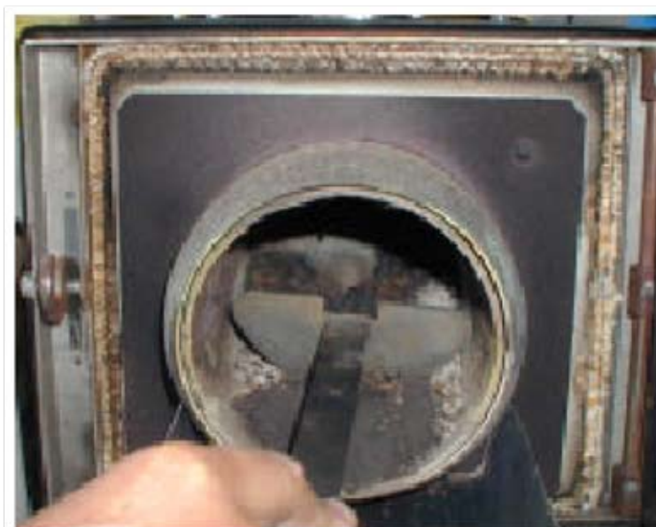
Skrapa ur aska och slagg med den medföljande askrakan.
